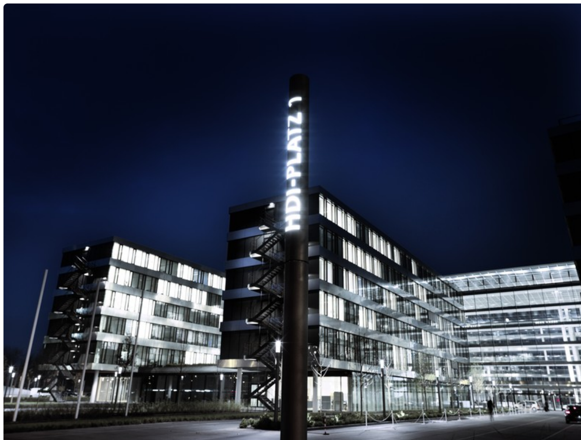
HDI Versicherung AG, Gebäude in Hannover
